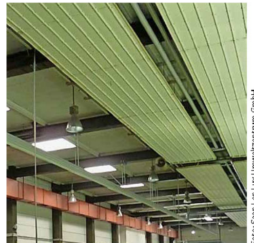
Deckenstrahlplatten sorgen für effiziente Raumwärme.
